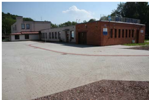
Příjezdová komunikace a parkoviště Horská 618 po rekonstrukci
