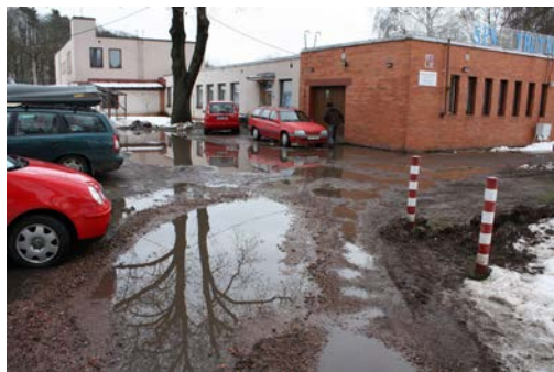
Příjezdová komunikace a parkoviště Horská 618 před rekonstrukcí
