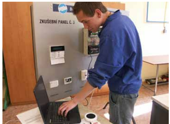
Zkušební panel zabezpečovací techniky
